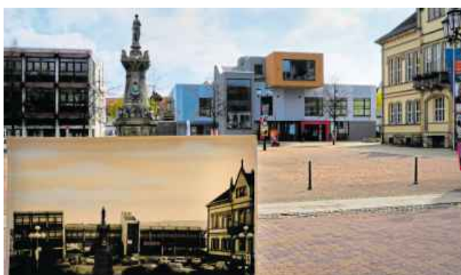
Ein Blick auf den Horner Marktplatz: Das frisch renovierte Gebäude, in dem auch die Sparkasse ihren Sitz hat, macht das Erscheinungsbild – im Vergleich zu früher – deutlich moderner.
