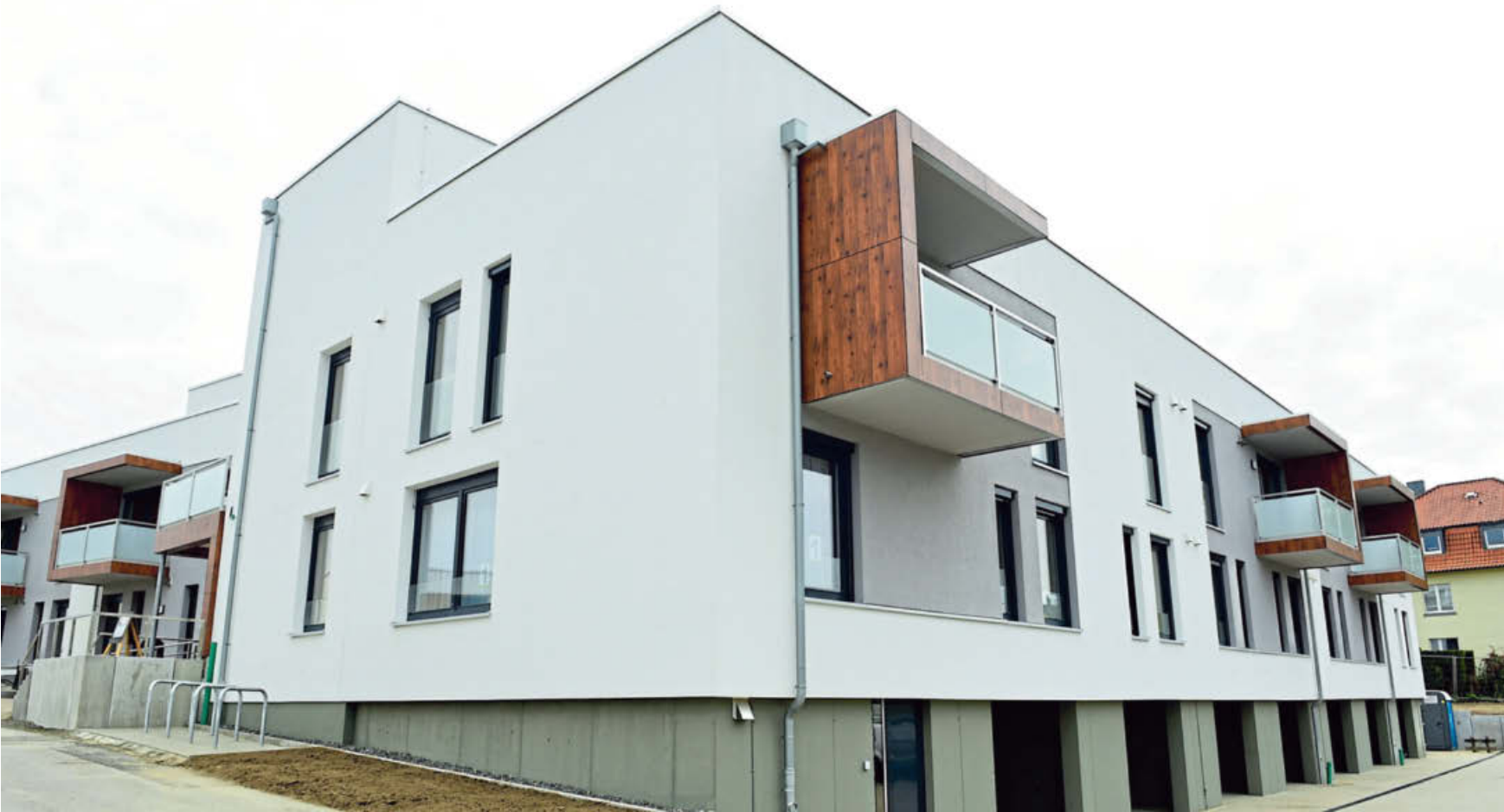
Der Neubau am Rostocker Weg lässt keine Wünsche offen. Viel Wert wurde darauf gelegt, dass die zukünftigen Bewohner, die mindestens dem Pflegegrad zwei angehören müssen, einen Großteil ihrer Eigenständigkeit im Alltag behalten. Knapp eineinhalb Jahre hat der Bau gedauert, nun sind die ersten Bewohner eingezogen. FOTOS: NICOLE ELLERBRAKE
