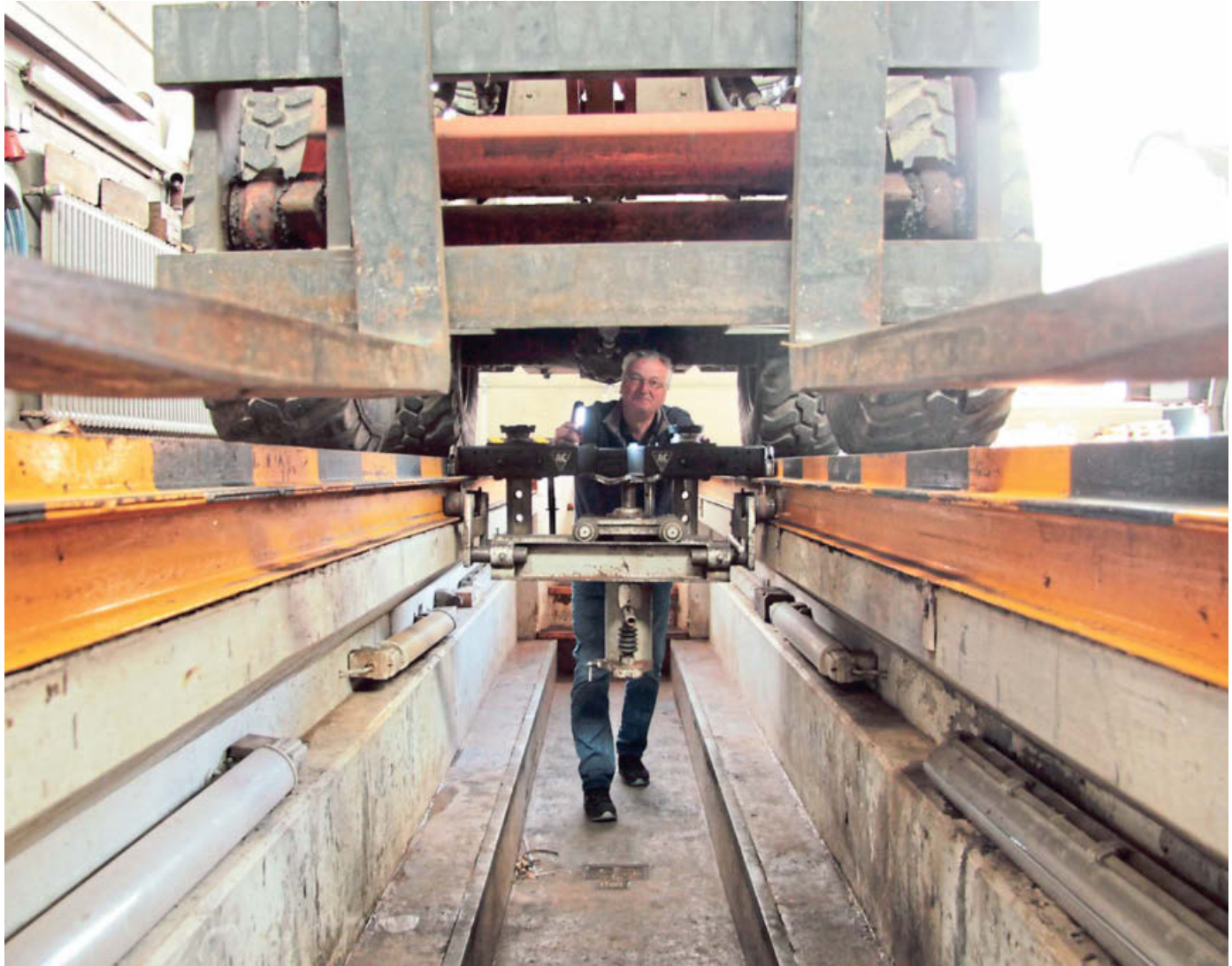
Mehr Platz und Technik in der neuen Fahrzeuggrube: Werkstattmeister Manfred Marx vom Kreis-Bauhof in Lieme freut sich auf mehr Komfort beim Gang unter die Fahrzeuge.
