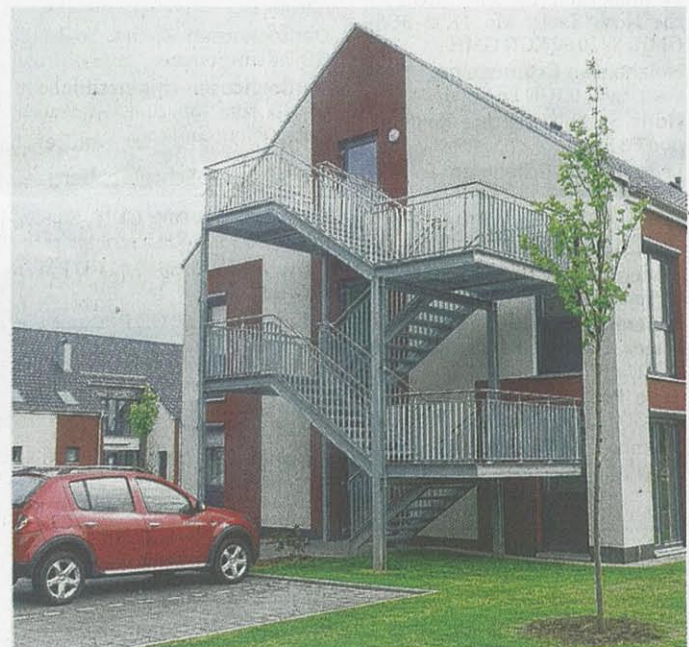
Gut gelöst: Das Wohnheim für 16 Plätze mit dem dahinter liegenden Apartmenthaus mit acht Wohnungen.
